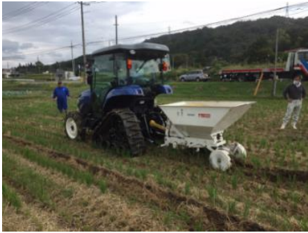
図2 モミガラ暗渠埋設機の施工状況（山口市仁保）
