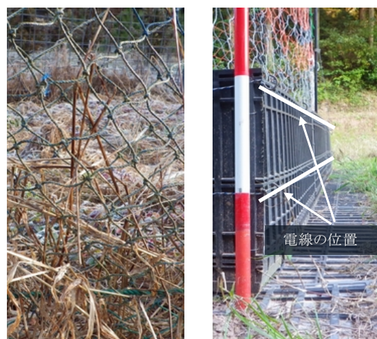
第7図 通常の網柵(左)と「改良柵b」(右)
