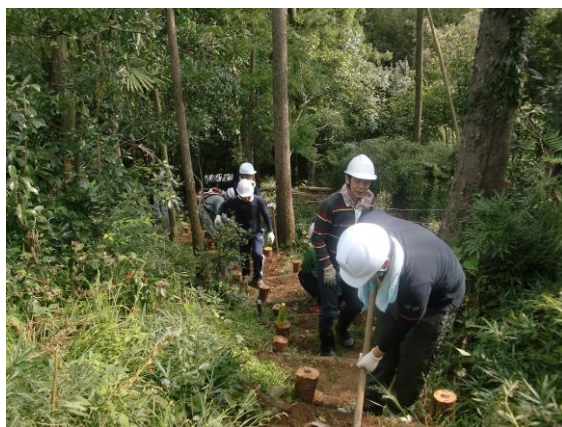
丸太を使った階段の設置作業
