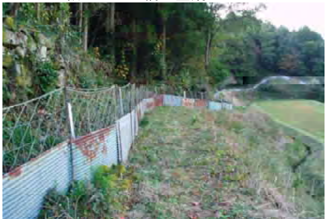
美祢郡美東町長田地区の事例（経費は金網フェンスの補強分m当たり553円）
