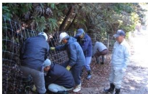
住民自らが侵入防止柵を設置
