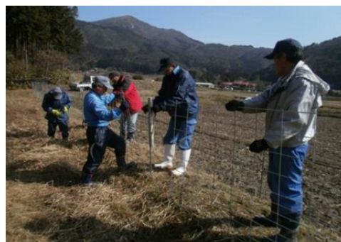
獣害防止柵の設置状況
