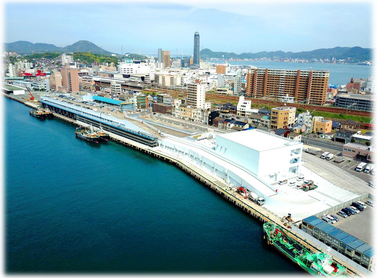
整備中の下関漁港（平成30年4月26日撮影）
