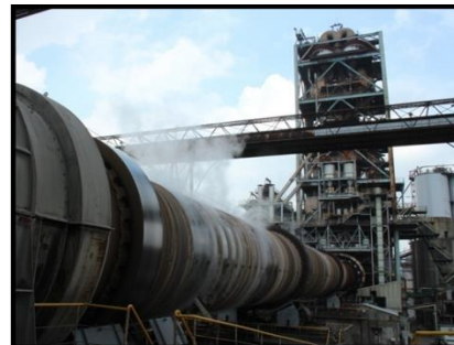
セメントプラント
