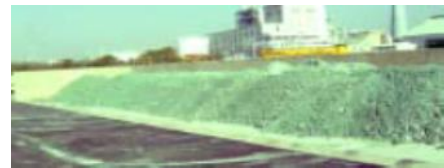
総合排水汚泥
