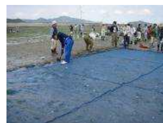
[ 被覆網の設置状況 ]
