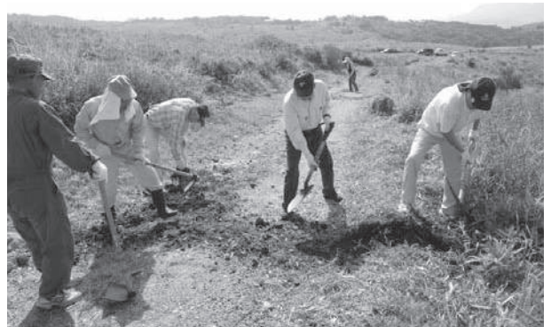
秋吉台での自然歩道の補修作業 (自然共生推進事業)
