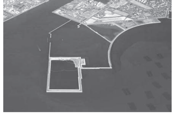
宇部市東見初地区広域最終処分場
