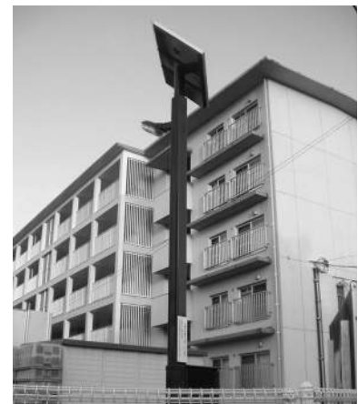
ソーラー外灯（東岐波団地）
