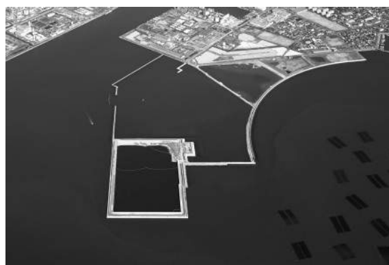
宇部市東見初地区広域最終処分場
