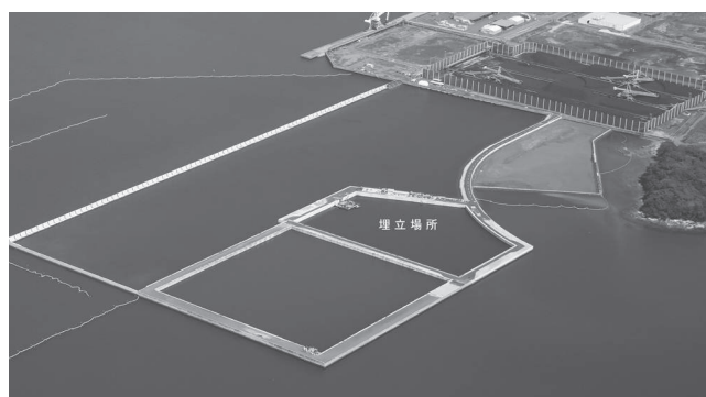
徳山下松港新南陽広域最終処分場
