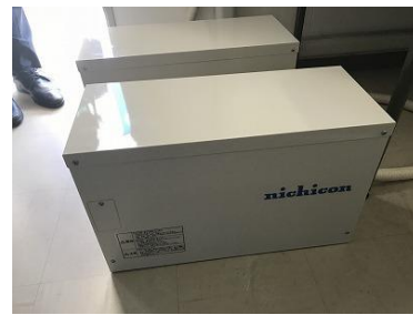
蓄電池ユニット
