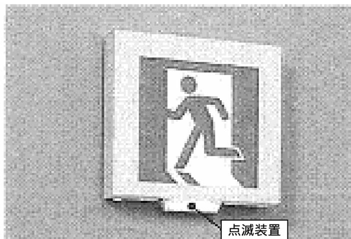
誘導音付点滅型誘導灯(電池内蔵型)
