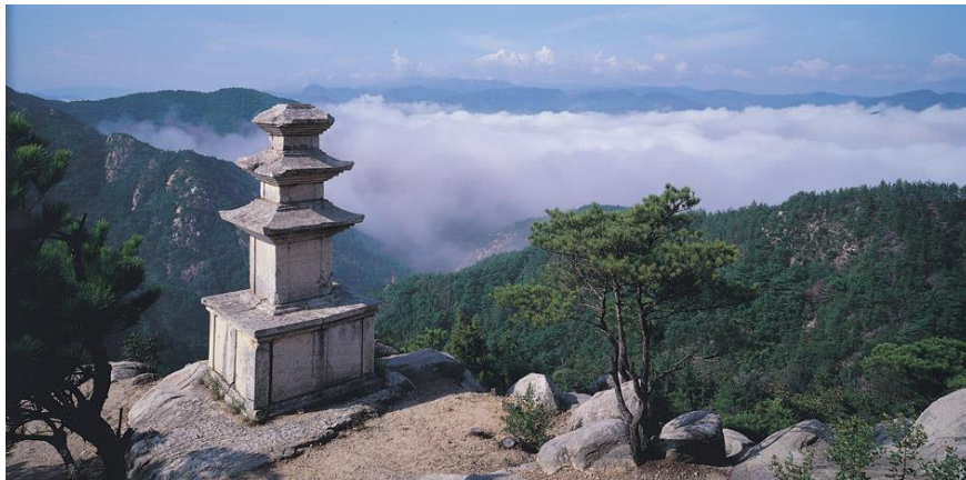
↑慶州南山の茸長寺谷三層石塔
