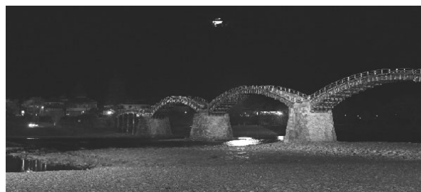
岩国市「錦帯橋」
