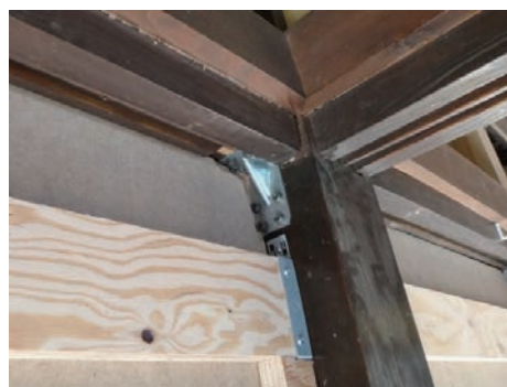
柱頭金物を取り付けた後
