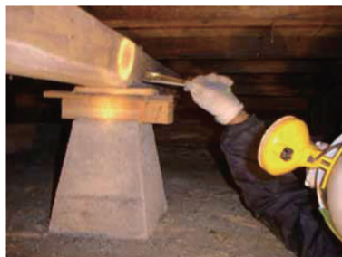
床下劣化調査
