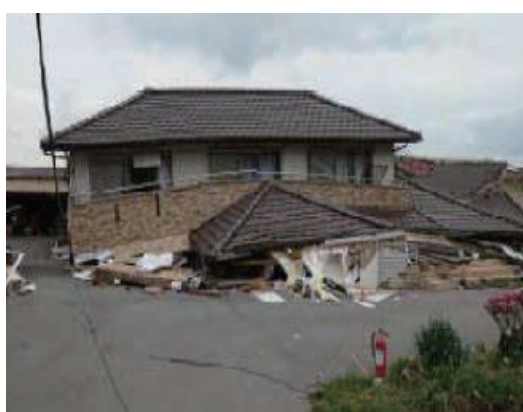
熊本地震で倒壊した木造住宅
