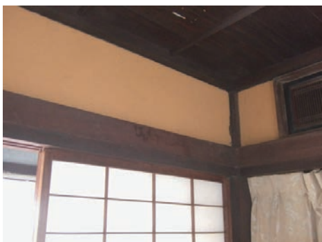
柱頭金物を取り付ける前
