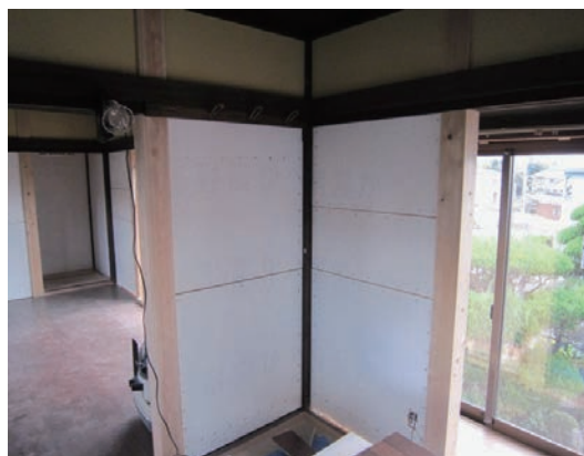
柱と壁を新たに施工
