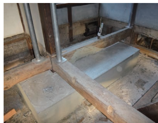
基礎を新たに施工
