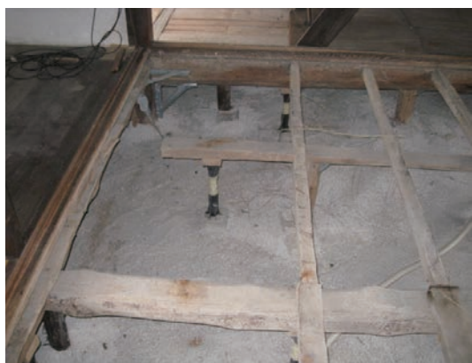
玉石の上に柱が立っている
