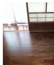
フローリングに改修
