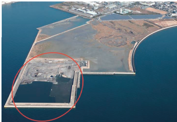
宇部港東見初広域最終処分場
