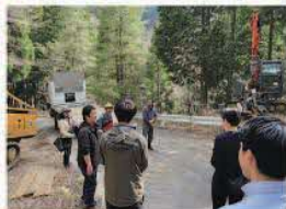
間伐を行っている現場をご案内
