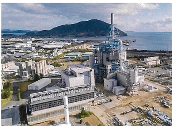
【工事開始後 18 ヶ月目】2018 年 12 月度建設状況 工事全体写真（12 月 29 日 ドローン撮影） 北西より望む
