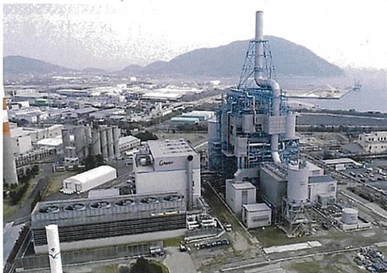
【21 ヶ月目】2019 年 3 月度建設状況 工事全体写真（3 月 1 日 ドローン撮影） 北西より望む
