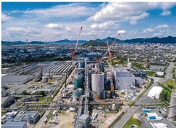
【工事開始後 15 ヶ月目】2018 年 9 月度建設状況 工事全体写真（9 月 22 日 ドローン撮影） 東より望む
