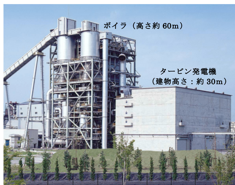
図2.2-5 類似施設の外観
