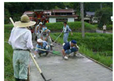
農道のコンクリート舗装
