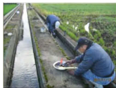
自主施工による目地補修
