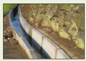
素堀り水路からの更新
