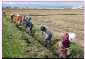
水路の泥上げ
