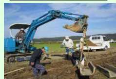
コンクリート水路の更新
