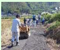
未舗装農道の舗装
