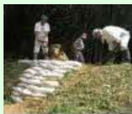
漏水箇所の補修
