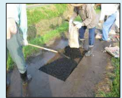
農道の部分補修
