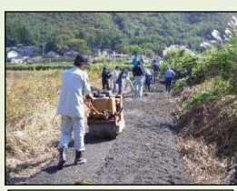
未舗装農道の舗装
