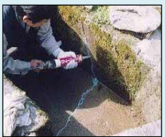
ひび割れの補修
