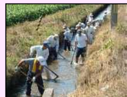
水路の泥上げ
