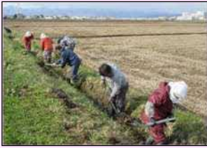
水路の泥上げ
