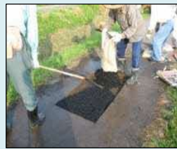
農道の部分補修
