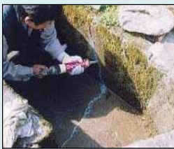
ひび割れの補修
