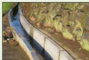
素堀り水路からの更新
