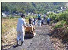
未舗装農道の舗装
