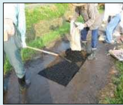
農道の部分補修
