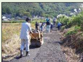
未舗装農道の舗装
