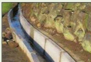
素堀り水路からの更新
