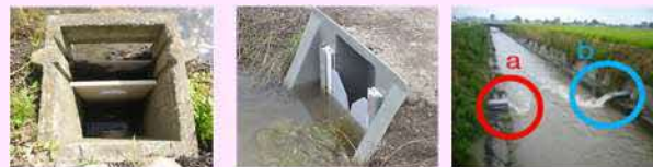
a 田んぼダム実施 b 田んぼダム未実施
