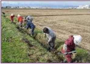
水路の泥上げ
