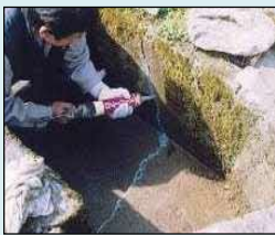
ひび割れの補修
