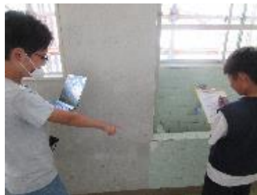
【安全点検の様子】
