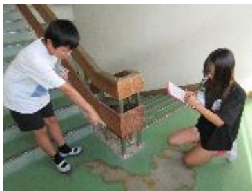
【安全点検の様子】
