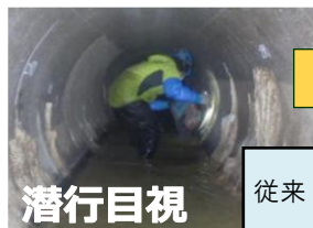
下水道管内の定期点検（例）
