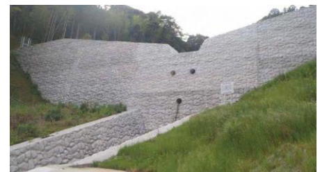
(奈古川 砂防ダム)
