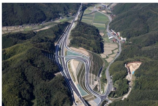
(山陰道 萩・三隅道路)
