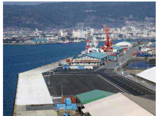
(徳山下松港 耐震強化岸壁)
