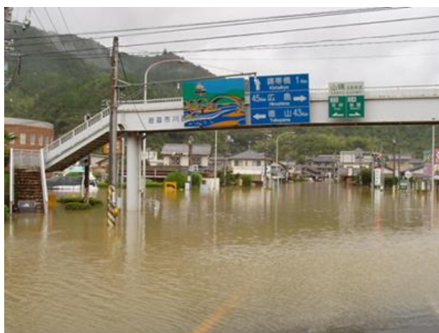
平成17年台風第14号被害 (岩国市川西交差点 冠水)
