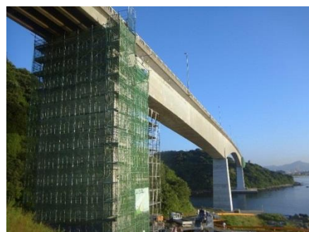
(彦島大橋 耐震補強)
