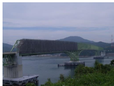
(大島大橋 橋梁補修)
