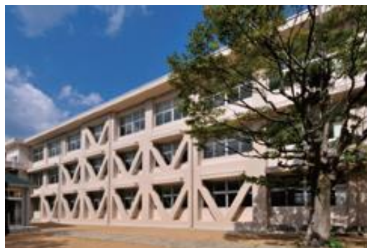
(耐震改修：大津緑洋高校)
