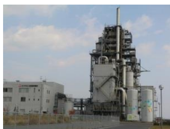
森林バイオマスの発電施設
