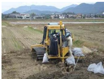
水田高機能化： 地下水位制御システムの施工
