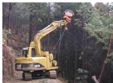
スイングヤードによる集材作業
