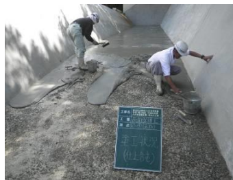
用水路の補修(長寿命化)
