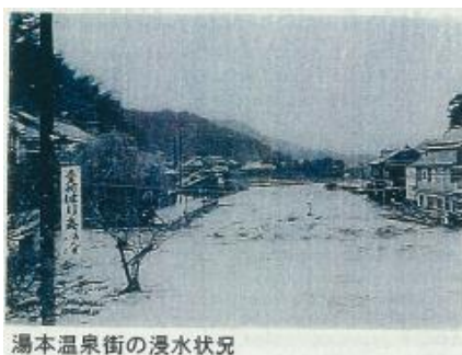
湯本温泉街の浸水状況
