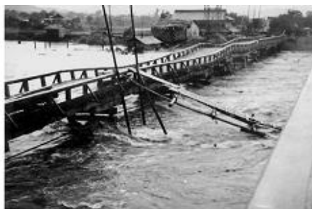
緑橋流出状況
