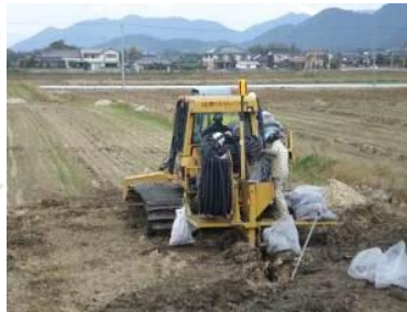
地下水水位制御システムの施工
