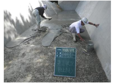
用水路の補修(長寿命化)
