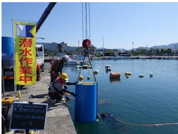
仙崎漁港防波堤補修
