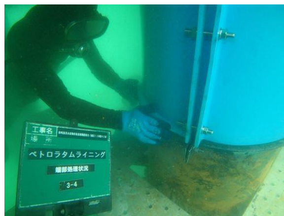
仙崎漁港防波堤鋼管基礎補修
