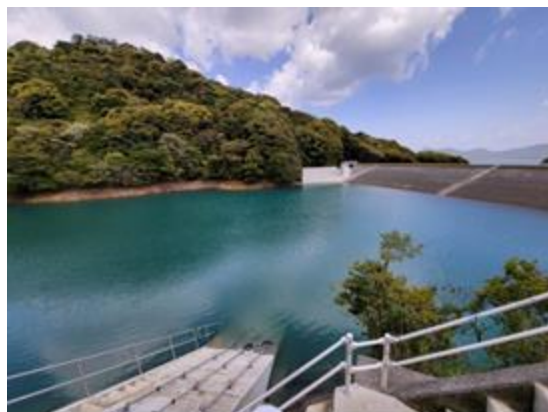
ため池の改修 （崩ノ河内第1地区）
