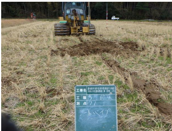
暗渠排水の施工状況 (黄波戸口地区)
