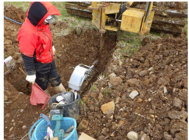
暗渠排水の施工状況 (黄波戸口地区)
