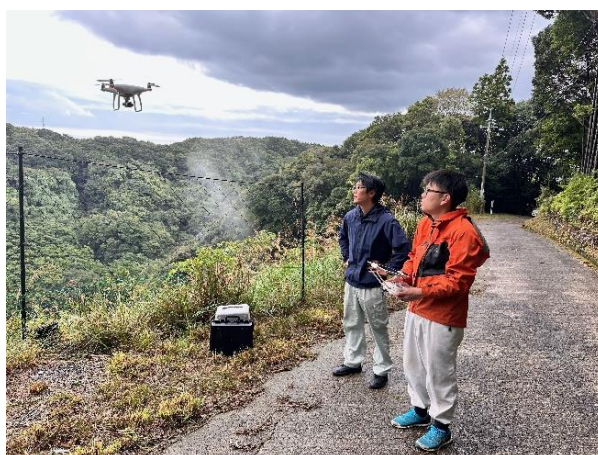
ドローンによるシカ防護柵の点検
