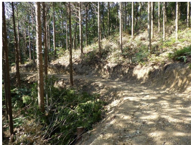
森林作業道の開設
