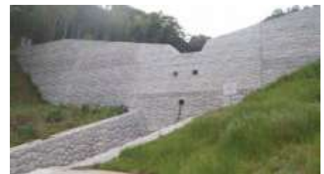
(奈古川 砂防ダム)
