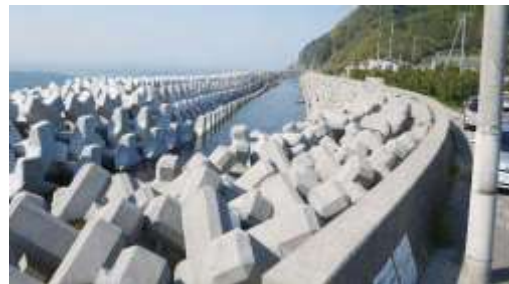
(徳山下松港 海岸高潮 (消波ブロック))
