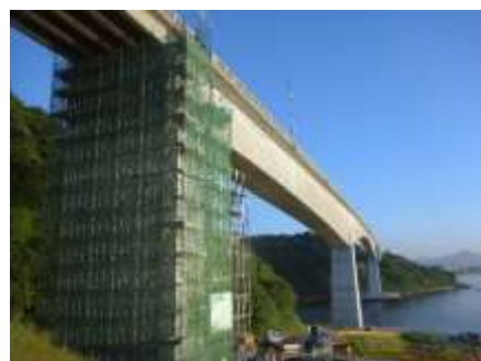
(彦島大橋 耐震補強)
