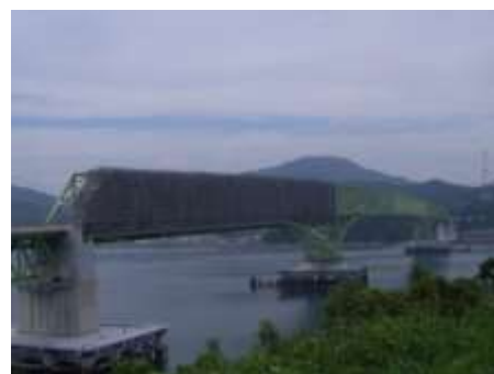
(大島大橋 橋梁補修)
