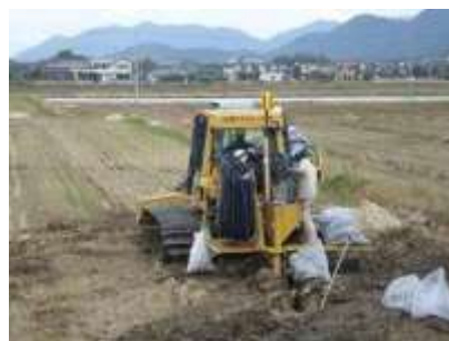
(水田高機能化 地下水位制御システムの施工)
