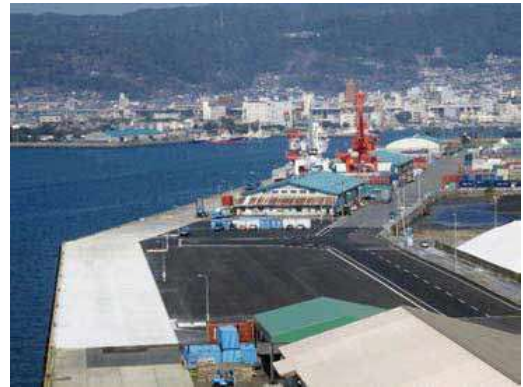
(徳山下松港 耐震強化岸壁)
