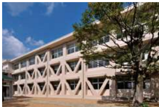
(耐震改修：大津緑洋高校)
