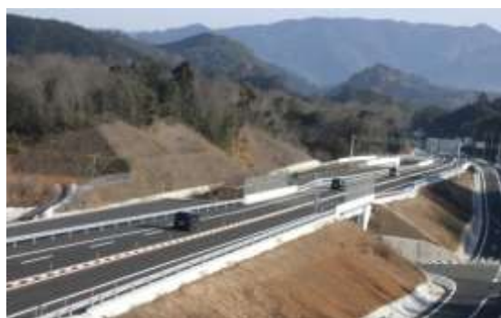
(地域高規格道路 小郡萩道路)
