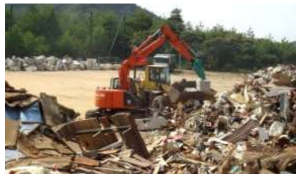
(集積された災害廃棄物の分別作業)
