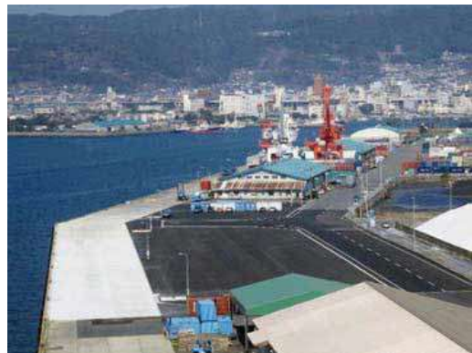
(徳山下松港 耐震強化岸壁)
