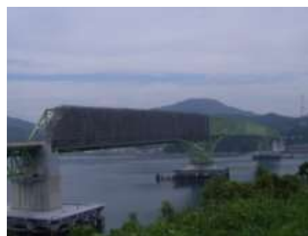
(大島大橋 橋梁補修)
