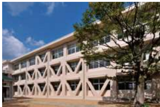
(耐震改修：大津緑洋高校)
