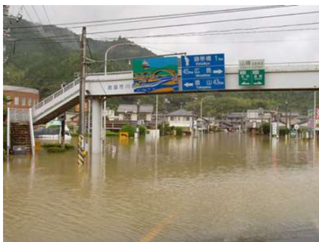
平成17年(2005年)台風第14号被害 (岩国市川西交差点 冠水)
