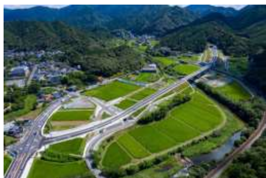
(山陰道 長門・俵山道路 長門湯本温泉インター付近)
