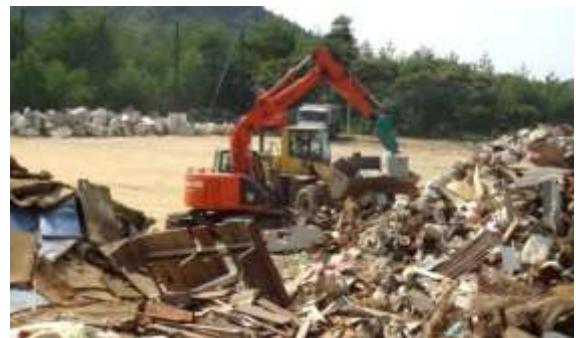
(集積された災害廃棄物の分別作業)
