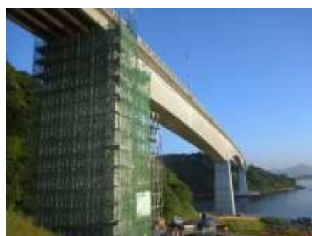
(彦島大橋 耐震補強)
