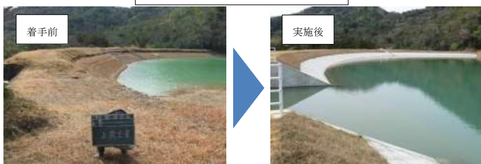
老朽化ため池（糸根新堤）の改修整備
