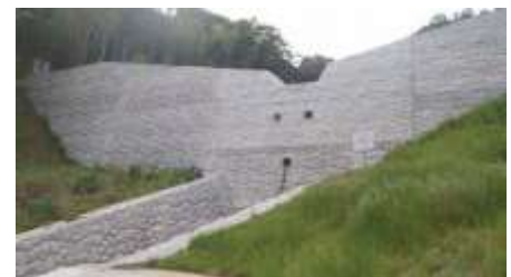
(奈古川 砂防ダム)
