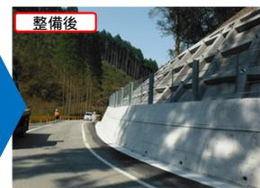
のり枠工 + 落石防護柵工
