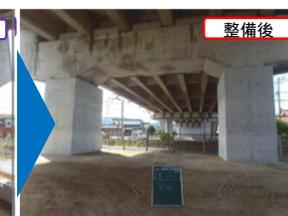
鉄筋コンクリート巻立て工法
