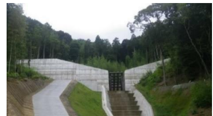
(松原溪流 砂防えん堤)
