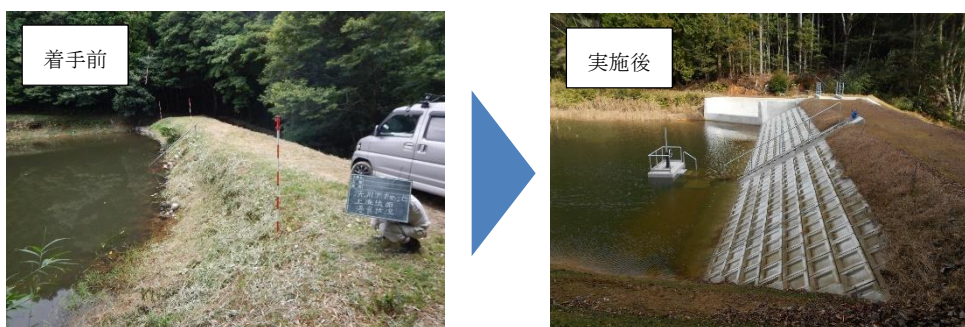
防災重点農業用ため池の改修整備
