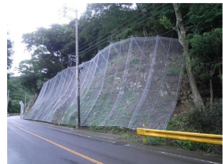
(県道萩篠生線 斜面の防災対策)
