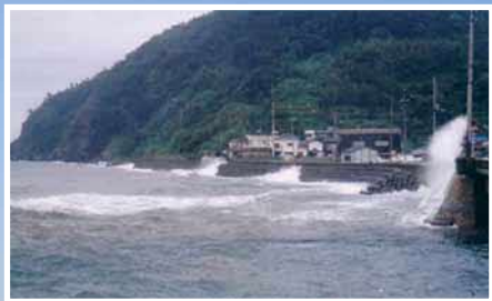
平成16年 台風18号での越波状況
