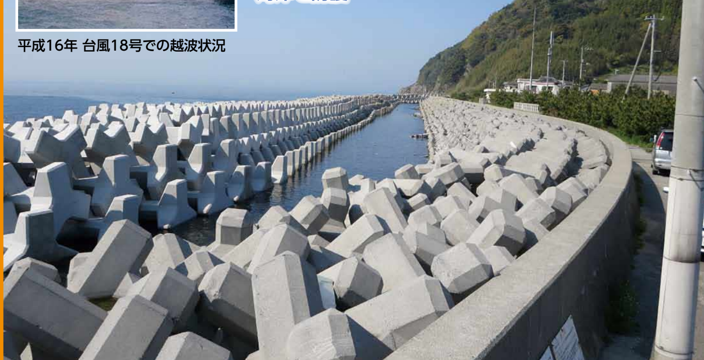
海岸高潮対策工事後
