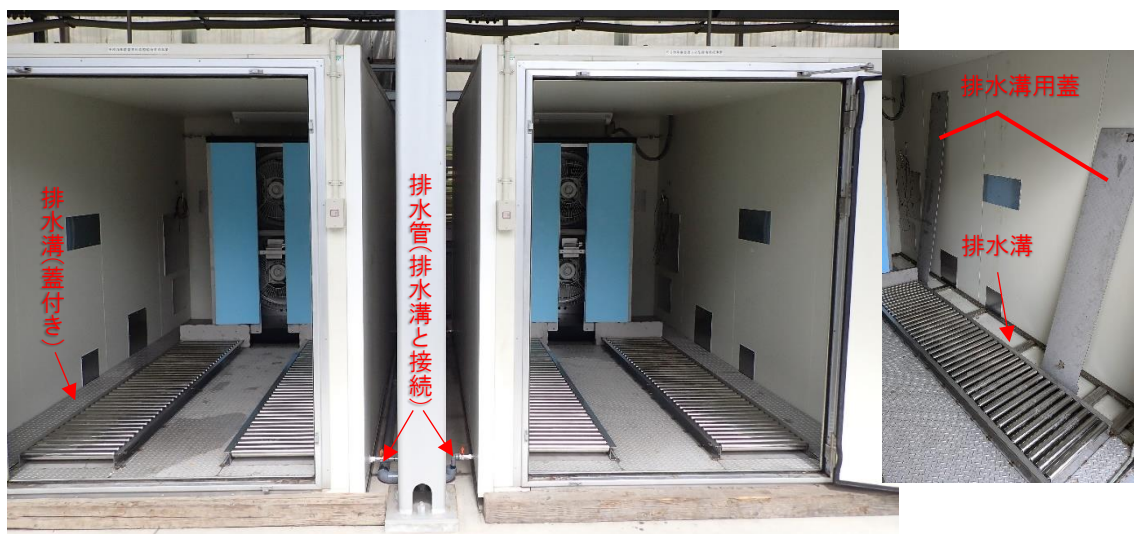
図2 蒸熱処理庫の排水設備の例(左)とその構造(右)
