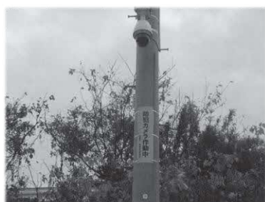
防犯カメラの設置
