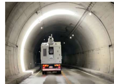
<トンネル点検の状況>
