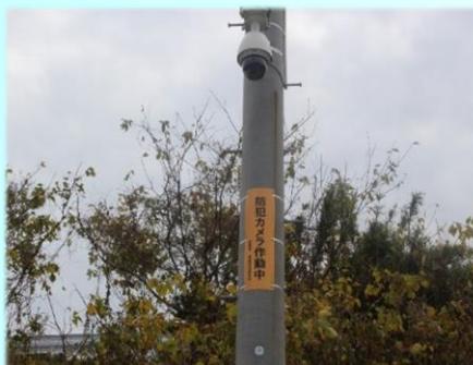
防犯カメラの設置
