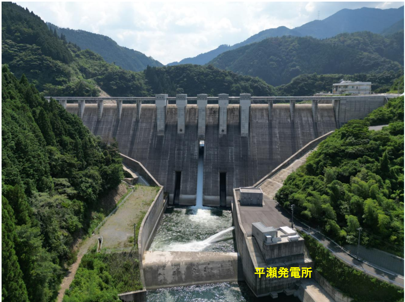
写真 平瀬ダム (下流から撮影)
