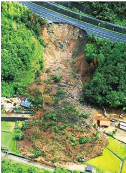
山陽自動車道の崩落(岩国市)
