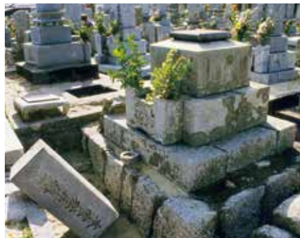
地震による被害
