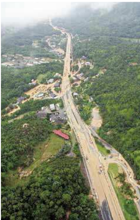
国道 262 号(防府市)
