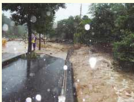
国道 262 号(防府市)
