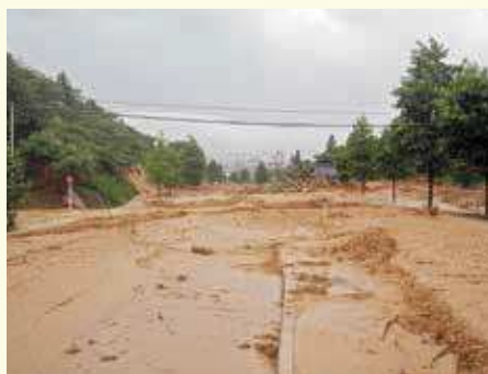
国道 262 号(防府市)
