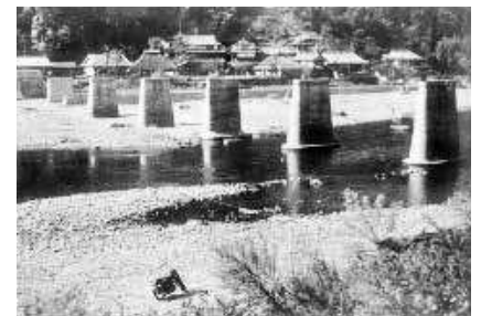
流失した天尾橋
