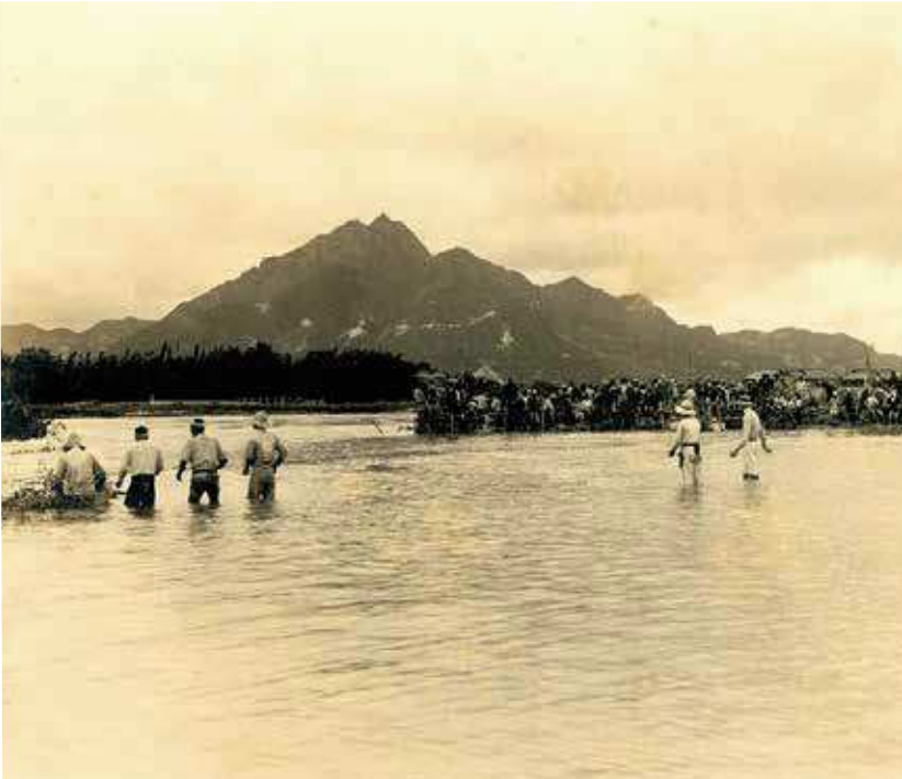
防府町字古曾原新橋下堤防決潰箇所 (山口県文書館所蔵)
