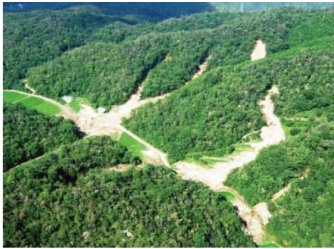
山口市楡畑の土石流現場
