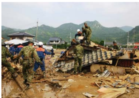
防府市真尾地区の住宅被害
