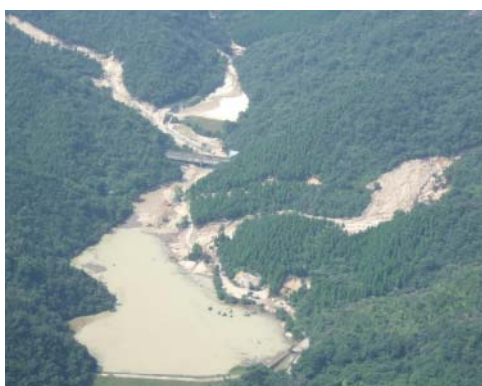
防府市内ため池土砂流入状況
