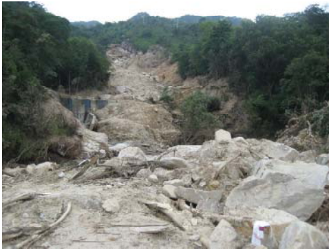
国道262号防府市勝坂の土石流現場
