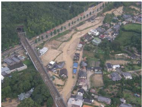
防府市剣川の被災状況
