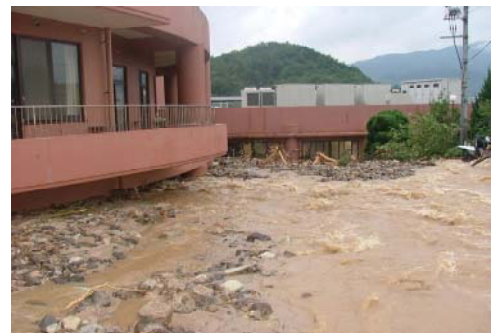
老人福祉施設 1階を埋めた土砂
