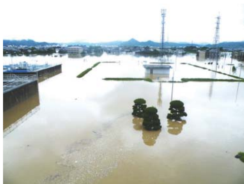
山口市朝田浄水場冠水現場
