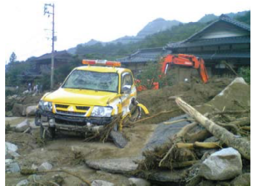
被災した道路パトロールカー（防府市勝坂）
