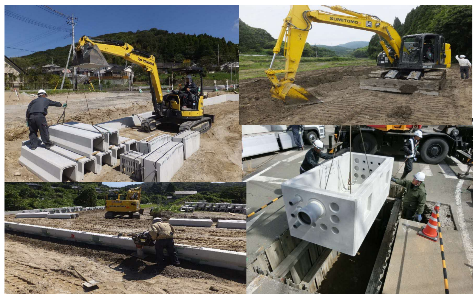
現場（電線類地中化事業他）の様子
