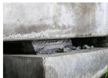
ゴム支承のせん断変形*3
