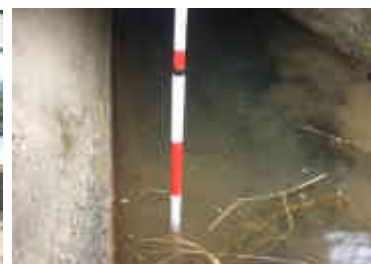
洗掘深さの計測状況
