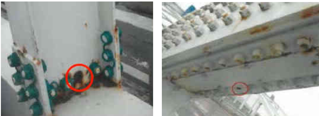
図 3.15 HTボルトの抜け落ち
