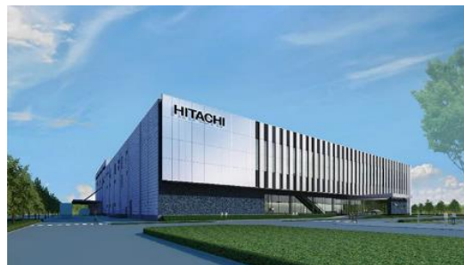
日立ハイテク・半導体製造装置の新製造棟建設
